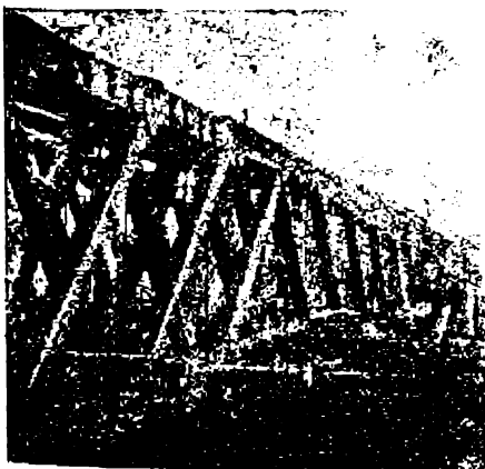
Сборка фермъ Гау съ подмостей (подъ шоссеюю дорогу).
